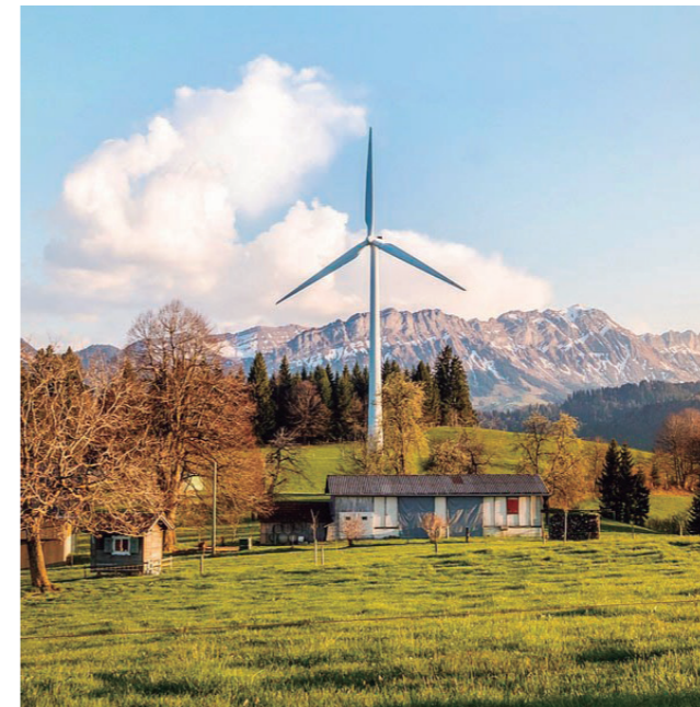
Abordar esta transición ofrece la oportunidad de generar empleo e infraestructuras verdes e impulsar la electrificación mediante energías renovables © Lucas Bieri / Pixabay
