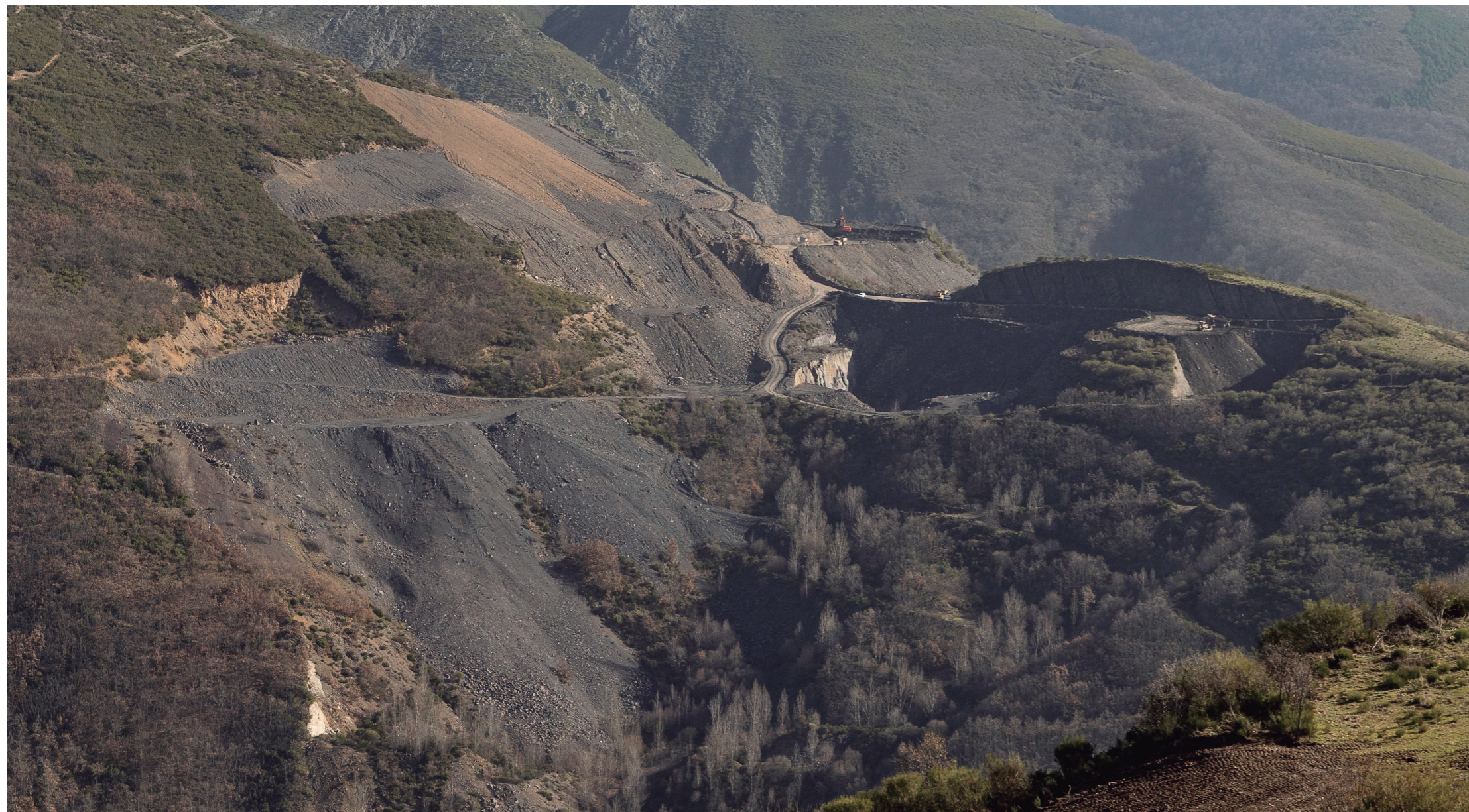
Explotaciones a cielo abierto y trabajos de restauración ambiental en Tremor de Arriba, pueblo ubicado en la Cuenca del Bierzo © Tragsa
